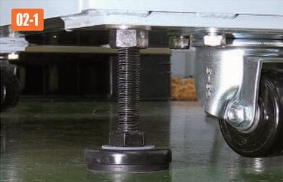
■ 床からアジャスターのナットの高さに合わせ、耐震マットがついたベース金具と固定金具を仮組みします。
