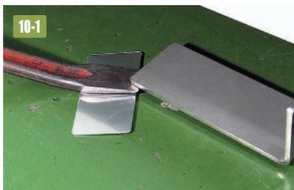
■ 残ったベース金具の取外しには、バールを使います。床が傷つかないように、バールの下に板を敷き、てこの原理で少し金具を浮かせます。
